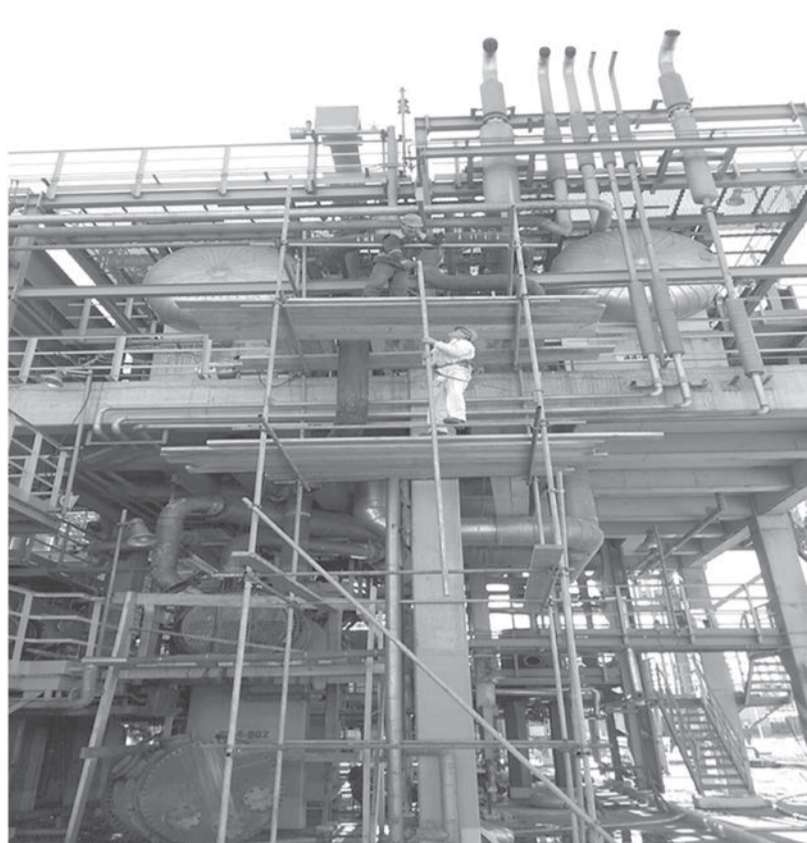
Монтаж строительных лесов - компания ТОО «ИнжПромКомпани»
