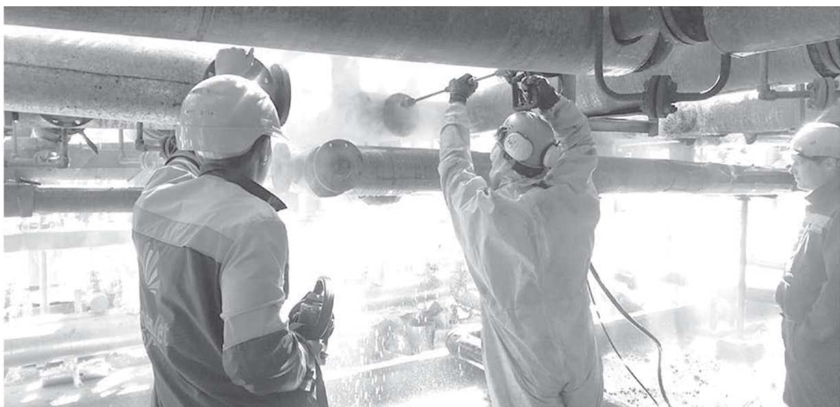
Чистка трубопроводов - компания ТОО «ИНТРА»
