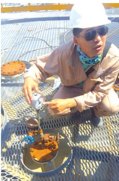
На технологической установке каталитического крекинга комплекса глубокой переработки нефти Атырауского НПЗ успешно завершены гидравлические испытания бункера хранения катализатора 3201-Т-0102.
